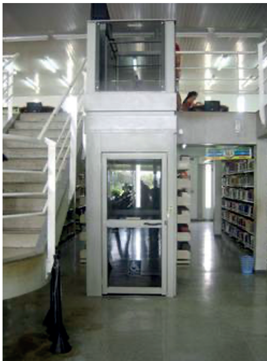
Figura 21 - Plataforma elevatória para pessoas com deficiência instalada na Biblioteca Central (2008)
