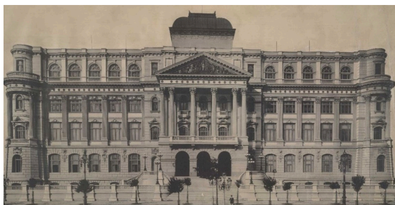
Figura 7- Fachada principal da Biblioteca Nacional (1910)
