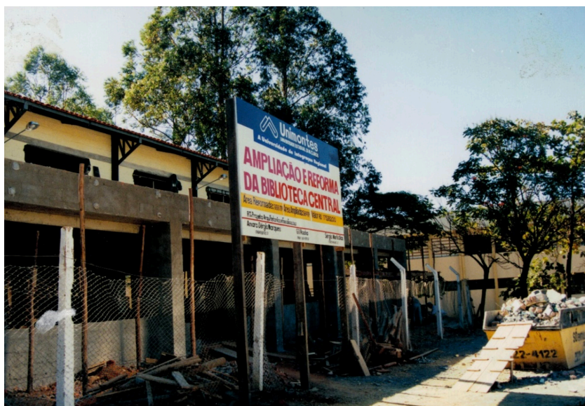
Figura 15 - Reforma e ampliação do prédio da BC/Unimontes (1999).
