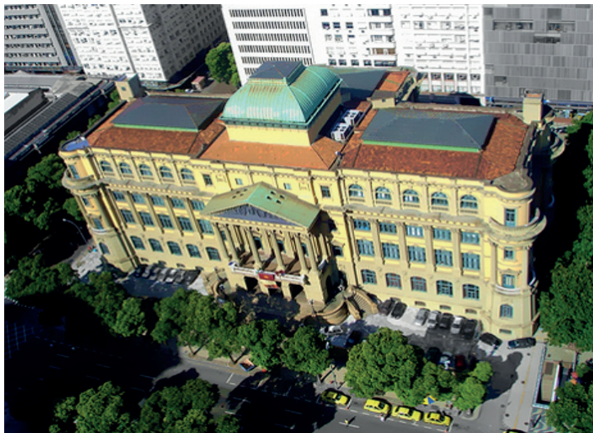
Figura 8 – Biblioteca Nacional. Detalhe das quatro claraboias que iluminam o interior do prédio (2009)
