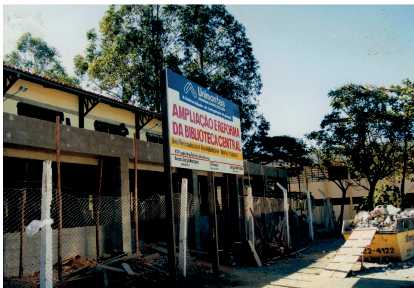
Figura 15 - Reforma e ampliação do prédio da BC/Unimontes (1999).
