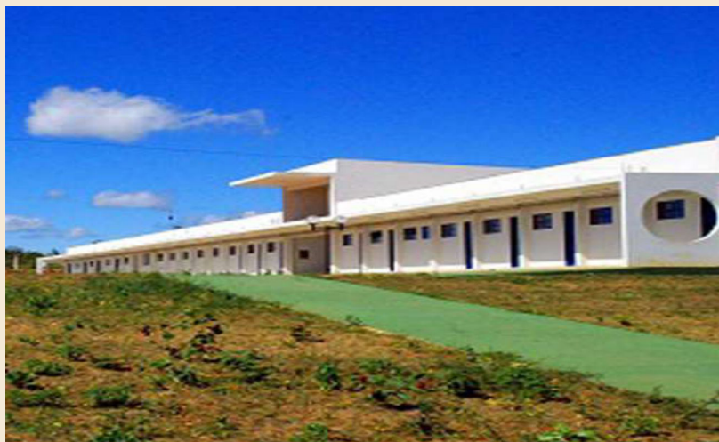
Figura 1 - Vista do prédio de Física no campus Bocaiuva
