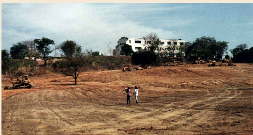
Figura 1 - Obras de terraplanagem para a construção do Centro Esportivo da Unimontes
