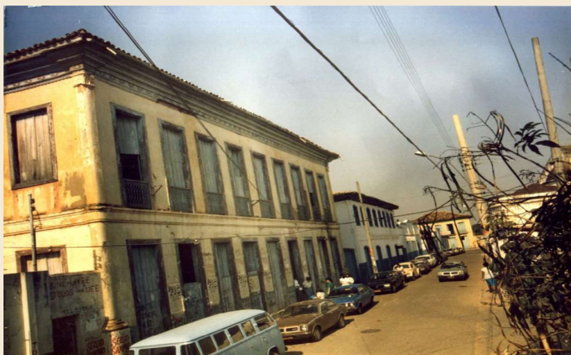
Figura 1 - Fachada do antigo prédio da Fafil antes da reforma
